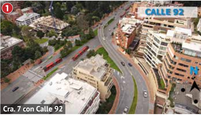
1 Cra. 7 con Calle 92 Troncal Carrera Séptima: Desde la Calle 34 a la 200, con ciclorruta desde la Calle 100 hasta la 200. Tendrá siete pasos a desnivel que también mejorarán la movilidad de los carros. Amplía la Séptima de dos carriles a seis de la 183 a la 200. Reducirá en más de una hora y media diaria el tiempo de viaje a 500 mil personas.
