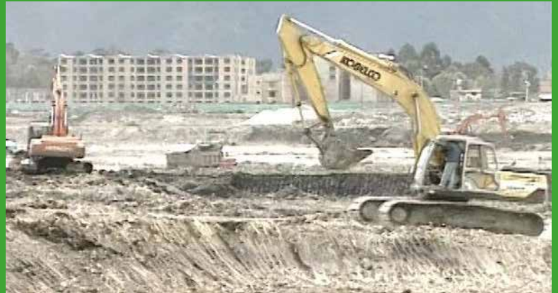
2. Con máquinas se construyó la laguna.
