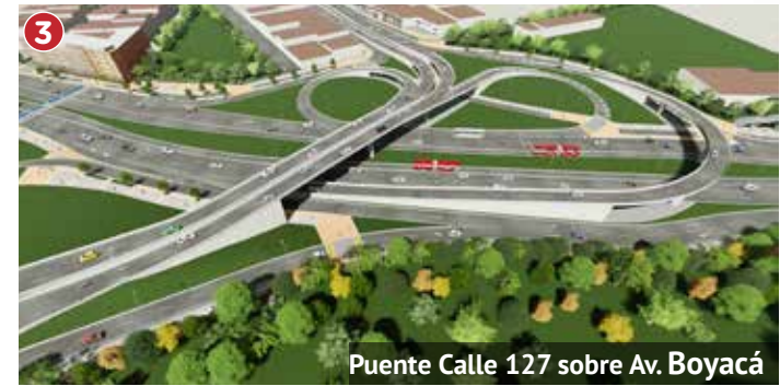
3 Puente Calle 127 sobre Av. Boyacá Avenida Rincón - Tabor y puente de la 127 sobre Av. Boyacá: La Alcaldía Peñalosa ya inició las obras de la prolongación de la Av. 127 al occidente con un puente sobre la Av. Boyacá y su continuación hacia el occidente para empalmar con la Av. Rincón-Tabor, que la Alcaldía construyó durante los últimos 3 años. Esta vía bordeará el formidable Parque de Cometas y pasará frente al nuevo Centro Felicidad-CEFE que allí se ubicará.
