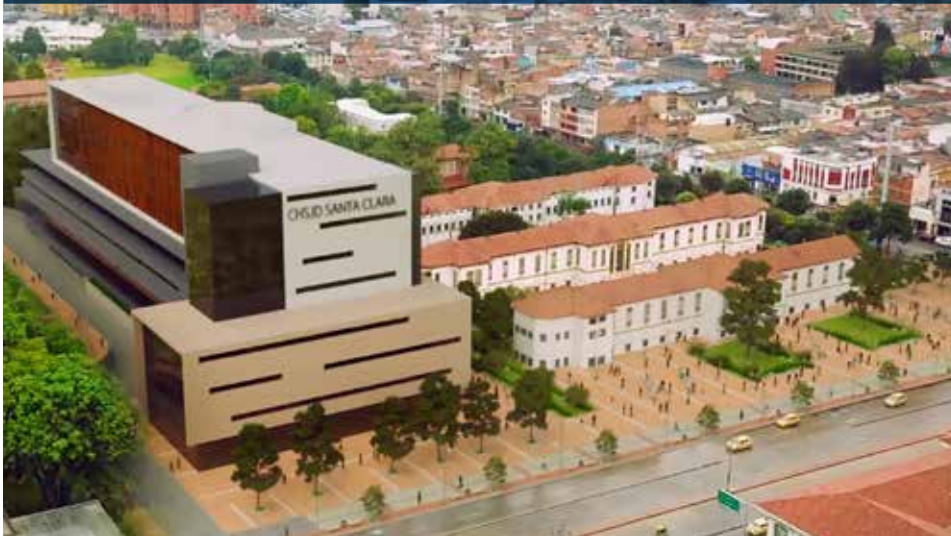
Nuevo Hospital Santa Clara (Complejo San Juan de Dios)
