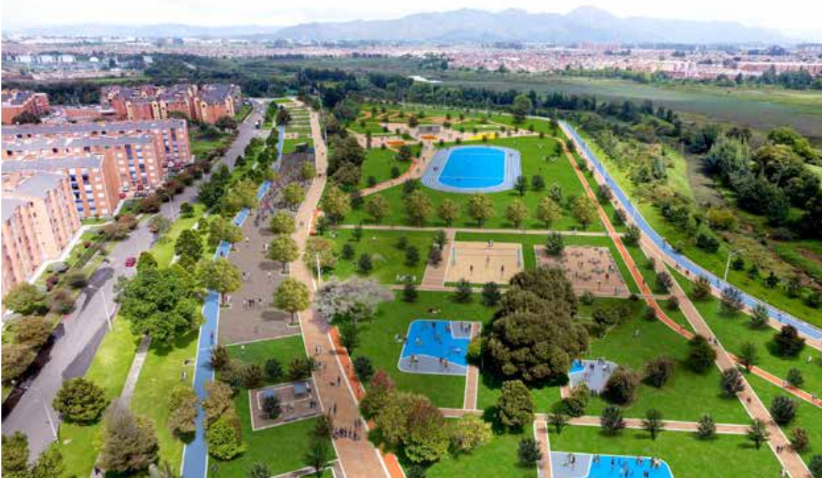
Así quedará el parque Colsubsidio-Juan Amarillo
