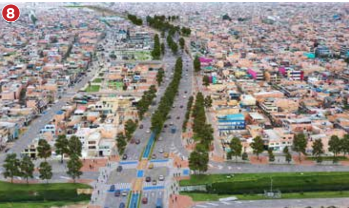
Avenida Guayacanes: Atraviesa Kennedy y Bosa. 13 kilómetros de vía de 6 carriles, con aceras amplias y ciclorruta. Para hacerla fue necesario comprar y demoler más de 1.400 edificaciones.
